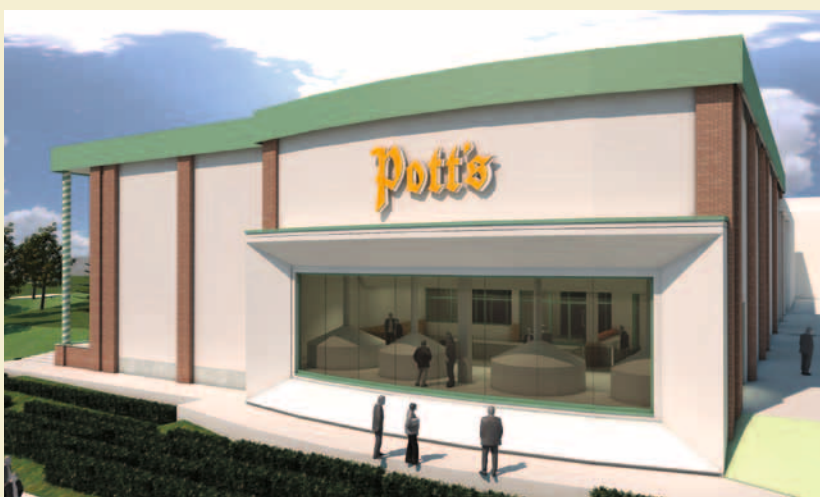
Nicht nur die Mitarbeiter der Pott's Brauerei erwarten sehnsüchtig die Fertigstellung und Eröffnung des Neubaus
