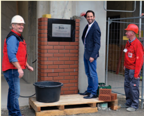
Unter fachmännischer Anleitung von Bauleiter Wolfgang Honnigfort (links) und Herbert Brockfeld (rechts) setzte Jörg Pott den Grundstein
