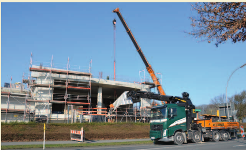
Zwei Spezialkräne waren bei der Anlieferung der Anlagenteile nötig
