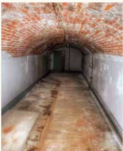
Der alte Gewölbekeller ist eines der historischen Highlights
